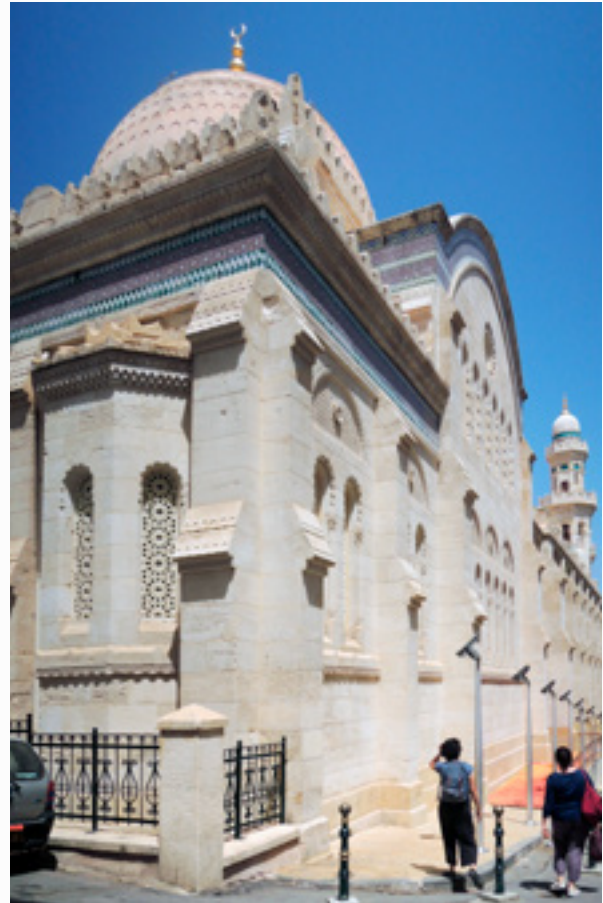
Fig. 3 : Mosquée Ketchaoua, place Ibn Badis, Alger, reconstruite entre 1844 et 1890
